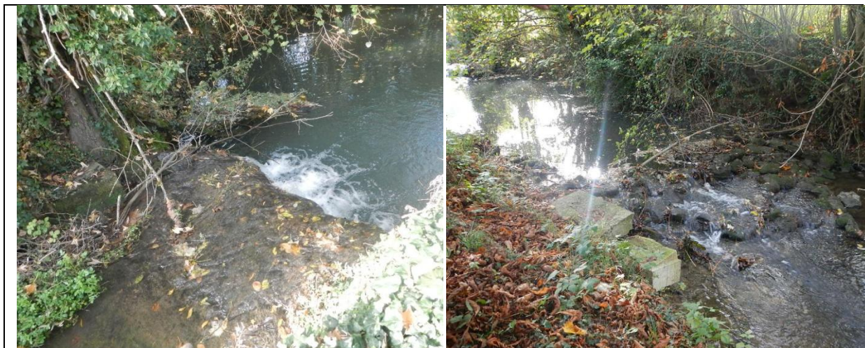
Le seuil Poulnot associé à un seuil artisanal en sortie de fosse. hauteur cumulée théorique 0.90m
